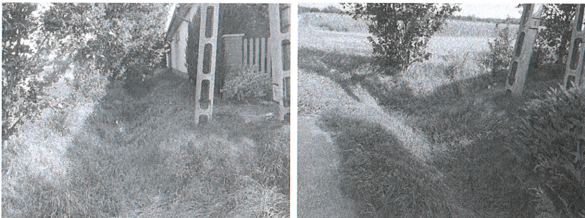
405/22 hrsz árok balra, jobbra a Rét utca nyílt árkanak bekötése a 405/22 árokba
